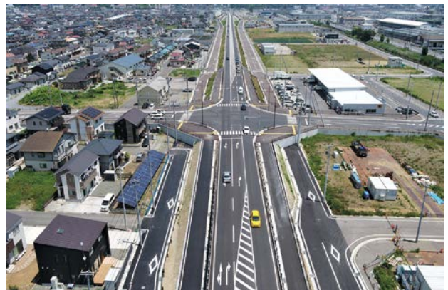
門脇流留線周辺の空撮写真
