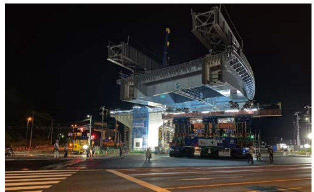
多軸式特殊台車による桁運搬状況
