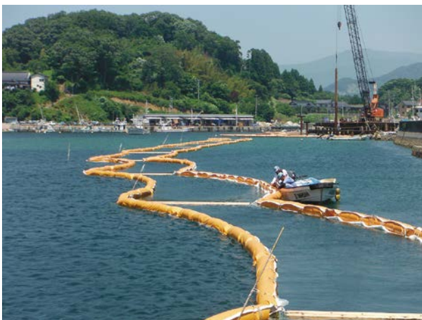
養殖業に配慮した施工状況
