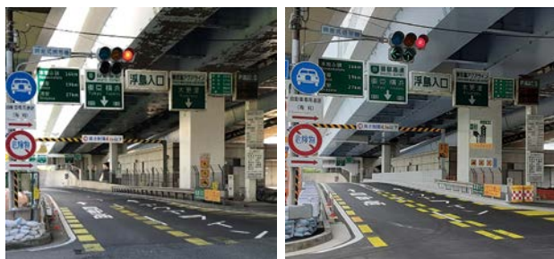
浮島入口（左：施工前、右：施工後）
