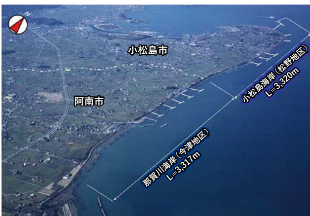
小松島海岸（坂野地区）と那賀川海岸（今津地区）の状況
