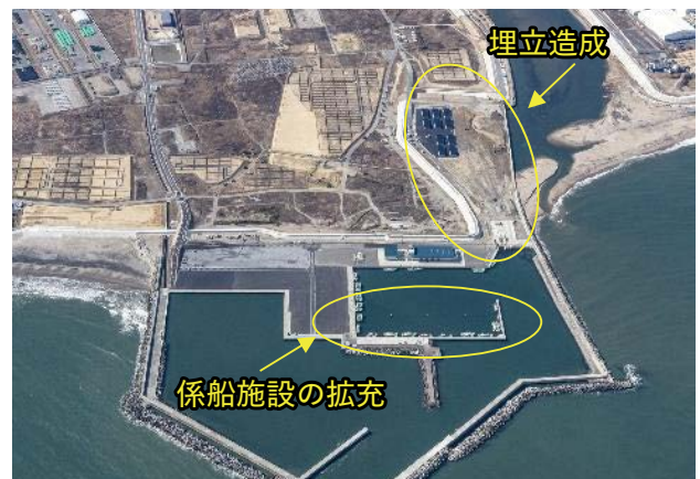
復旧工事完了後の請戸漁港
