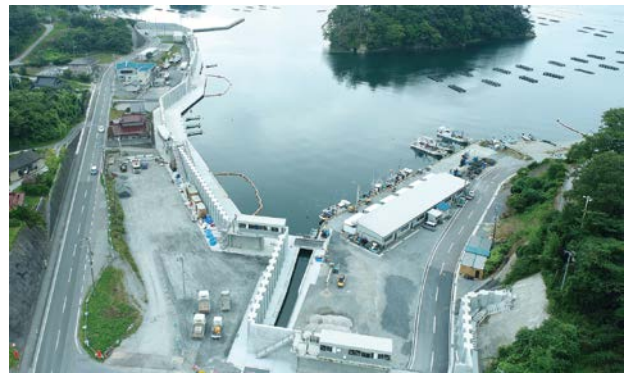
完成した防潮堤
