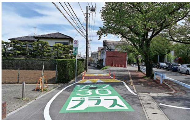
入口部狭さく・イメージハンプ設置状況
