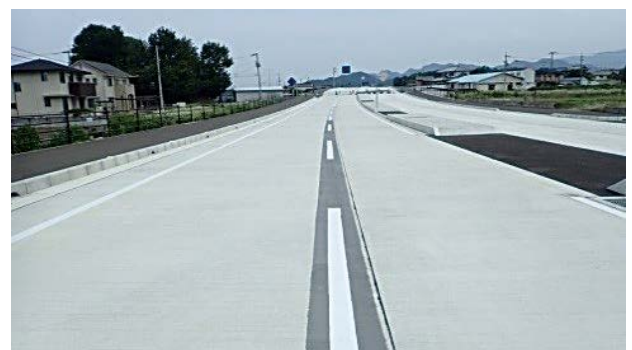
背景線の施工状況
