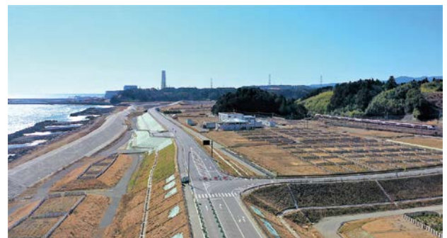
海岸堤防と道路改築事業 完了
