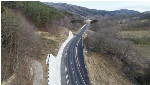
国道114号山木屋工区
