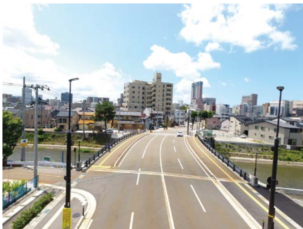
中島大橋全景（令和4年5月撮影）
