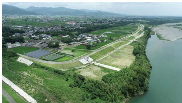
伊沢市工区（上流側）の堤防
