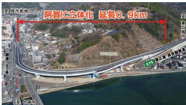
東広島呉自動車道阿賀IC立体化事業
