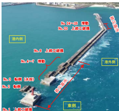
被災状況写真
