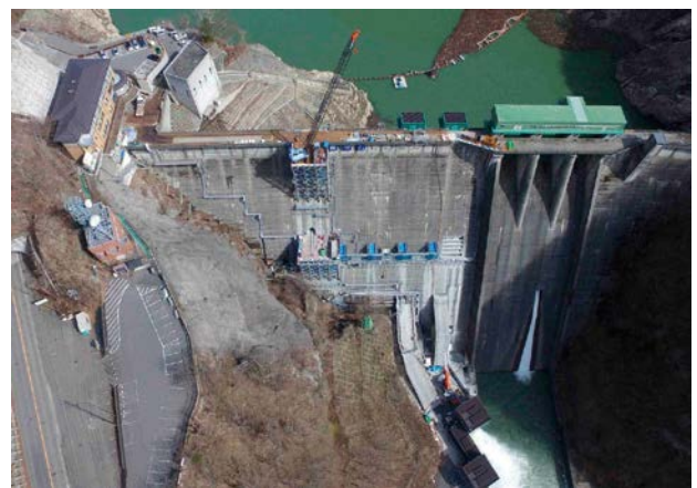
堤体削孔施工状況全景
