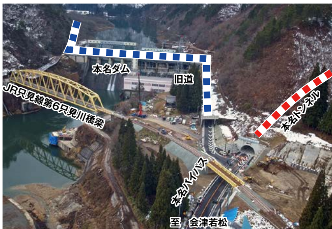
終点部から柏崎方向を臨む（現道状況）
