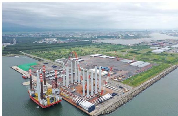
SEP船による風車部材の荷役状況
