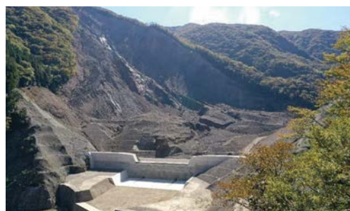
崩壊斜面直下に完成した赤谷3号砂防堰堤
