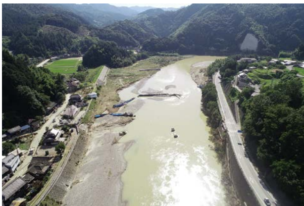
流失した大成橋（上流側より下流側を望む）
