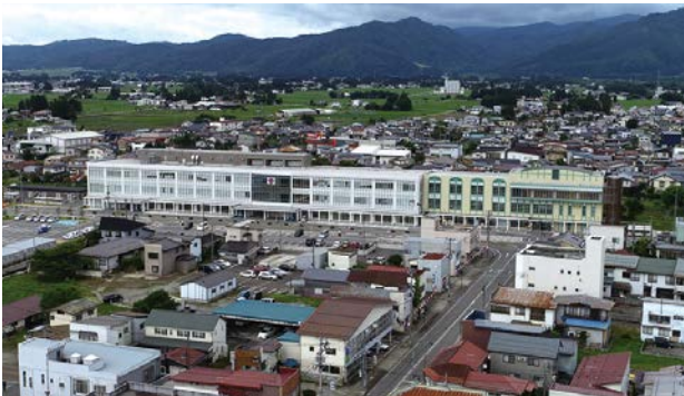
庁舎全景（左：市役所、右：まちなか交流施設）
