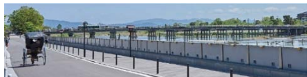
可動式止水壁（起立時）
