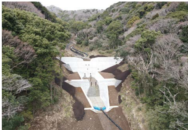
新設された「伊豆山砂防堰堤」
