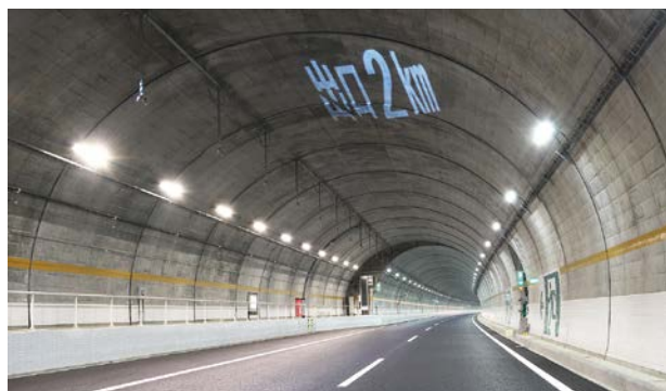
①トンネル内の投影状況
