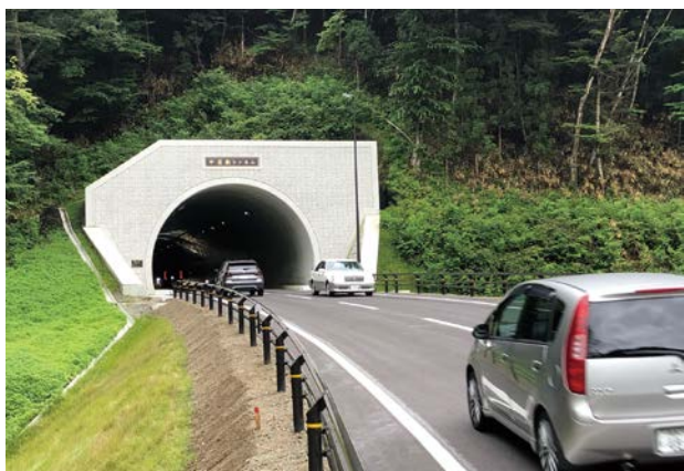
開通した野上小塚工区
