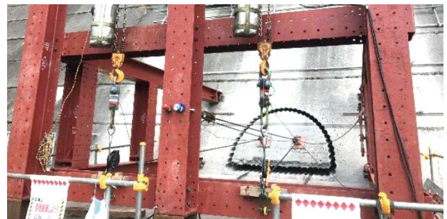
無振動大ブロック分割引出工法
